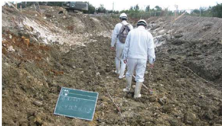
陸上水平探査状況 (経層探査 1m の例)
