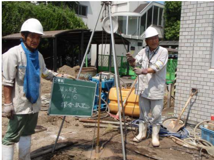
鉛直探査状況
