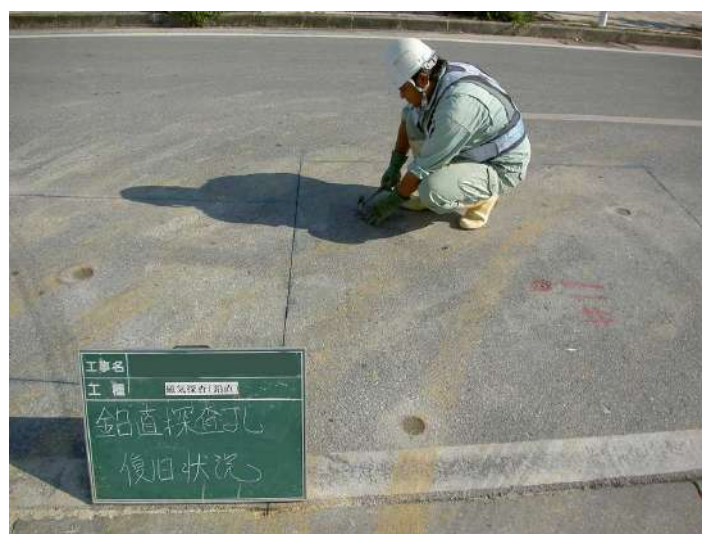
探査孔の埋戻し
