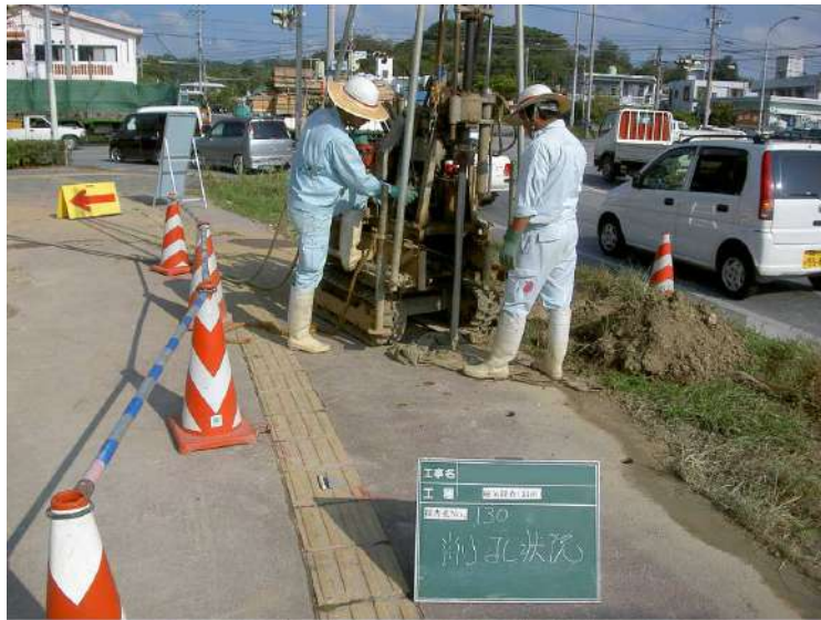
ボーリングマシンによる掘進状況
