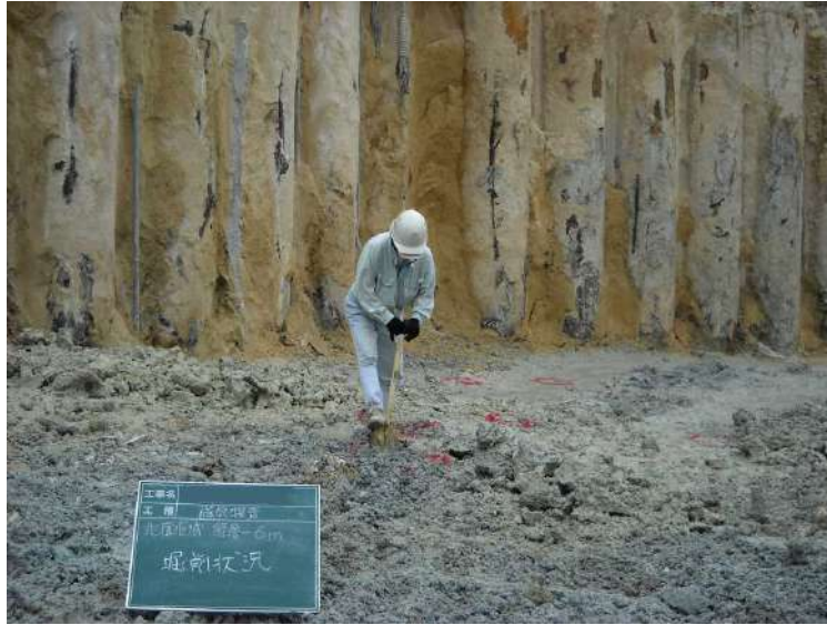
異常点の人力掘削状況
