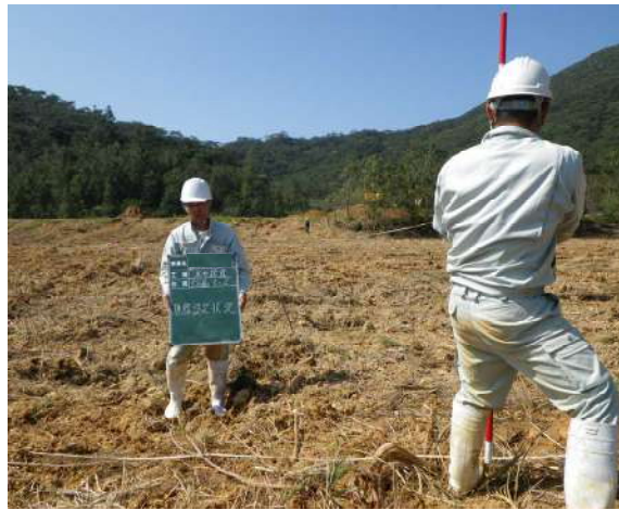
測線設定状況
