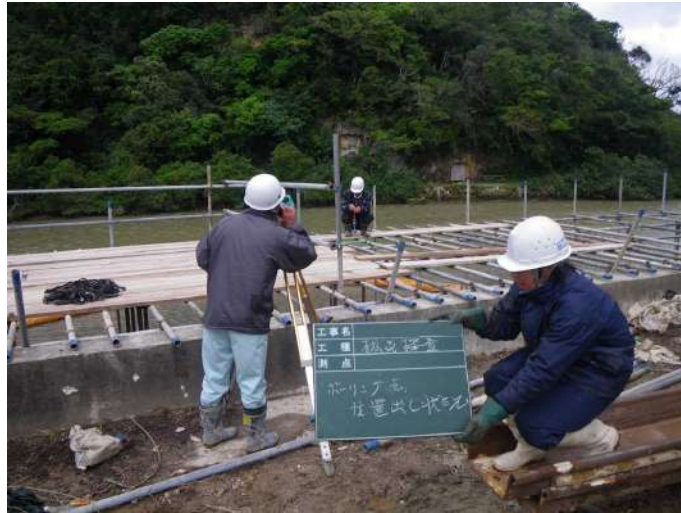
測量状況（鉛直探査）
